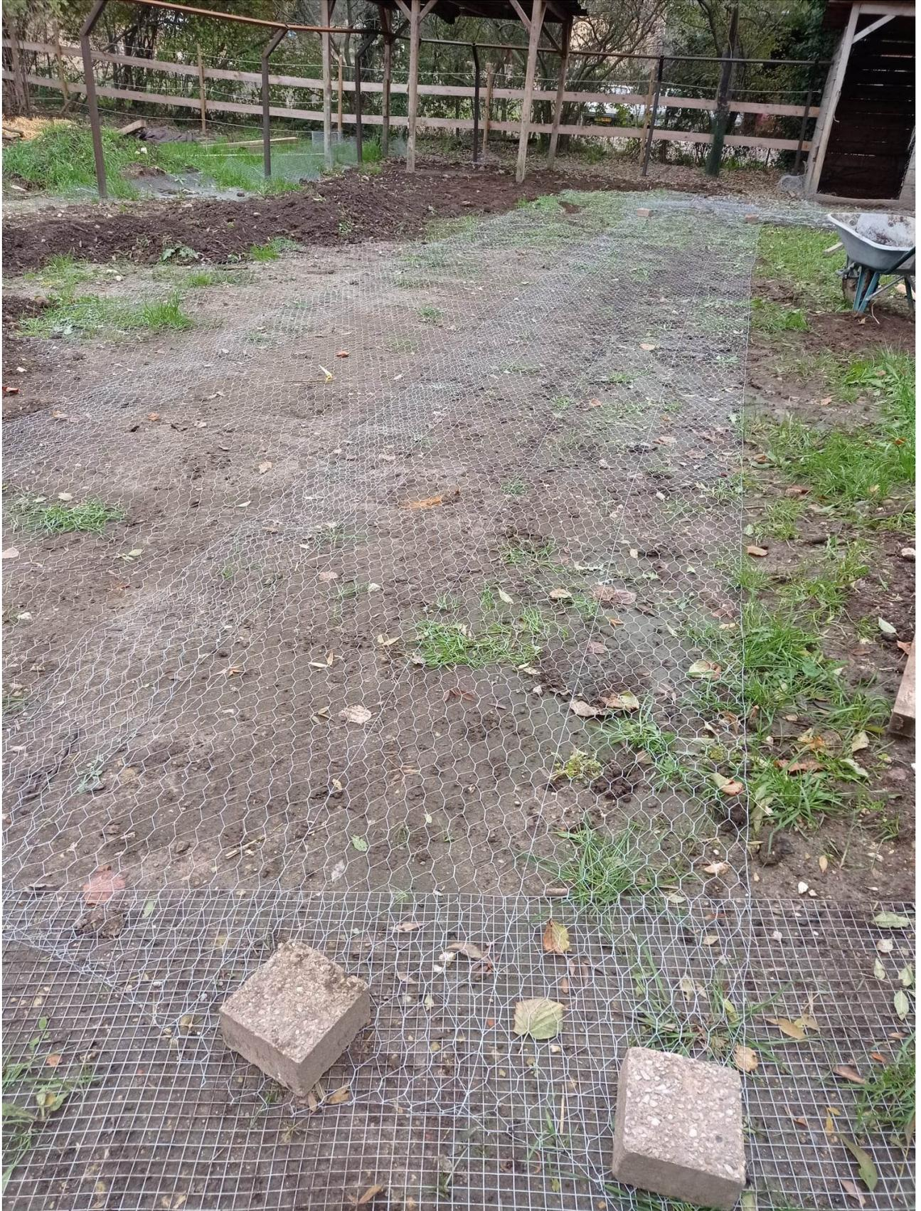
*Figure 12: Sol entièrement grillagé, avec recouvrement. Le grillage est enterré*
